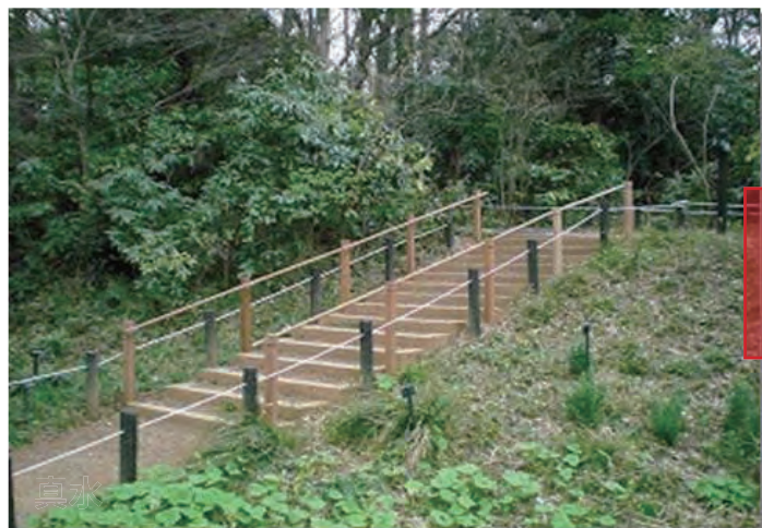
施工直後の階段、手摺。
