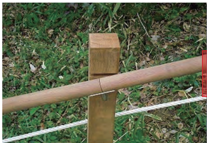
手摺：グリーンハートφ36 無垢材 受け金物：SUS製
